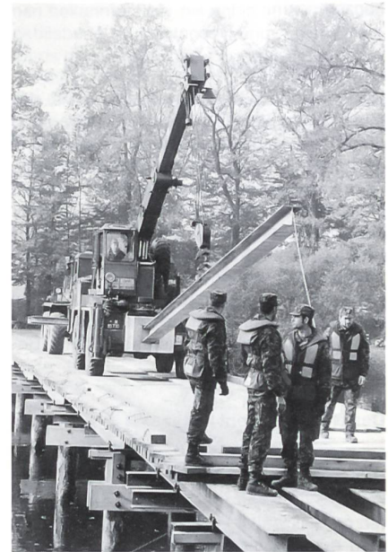
Beim Brückenbau (im Bild eine Feste Brücke 69, 50 t) aus Holz und Stahl...
