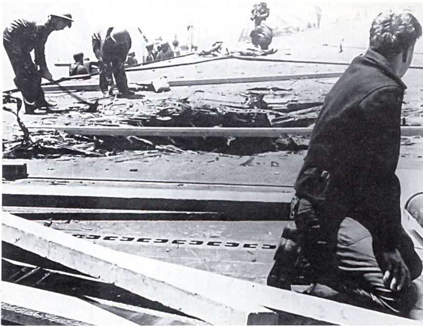
Amerikanische Seeleute versuchen, das schwer beschädigte Flugdeck der Yorktown behelfsmässig instand zu setzen.
