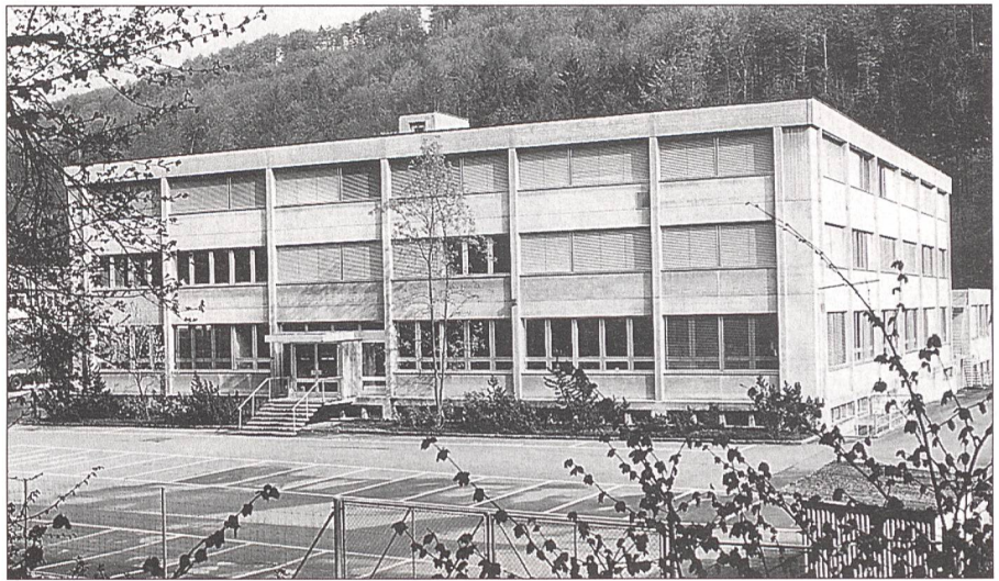
Das seit 1975 in Betrieb stehende Zeughaus.
