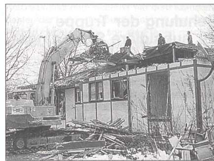
Nach 55 Jahren kam der Bagger und machte die Soldatenstube dem Erdboden gleich. (Fotos: Arthur Dietiker)
