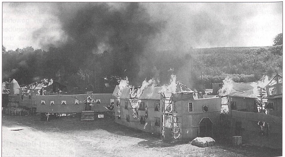
Nach der Explosion entwickeln sich Rauch und Feuer.
