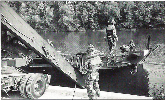
Sorgfältig wird ein Brückenmodul ins Wasser gelassen.
