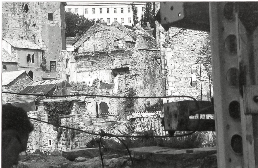
Hier führte in Mostar die alte türkische Brücke über die Neretva. Sie wurde im November 1993 im kroatisch-muslimischen «Krieg im Krieg» zerstört.
