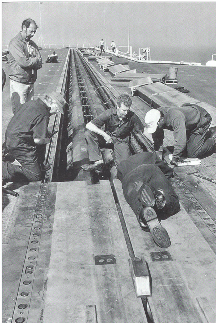
Vier etwa 90 m lange Dampfkatapulte beschleunigen die Kampfflugzeuge des Nuklearflugzeugträgers «USS George Washington» in nur 2 Sekunden von Null auf rund 220 km/h. Hier ist das Katapult Nr. 1 der «USS George Washington» zu Wartungsarbeiten freigelegt, und die beiden Zylinder sind gut sichtbar, durch welche die mit dem startenden Flugzeug verbundenen Kolben mittels Dampfdruck beschleunigt werden.
