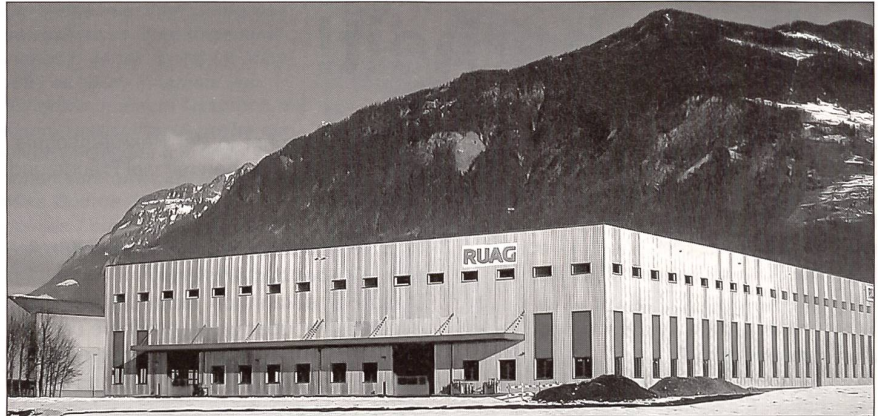
Neue Produktionshalle für RUAG Components in Altdorf.
