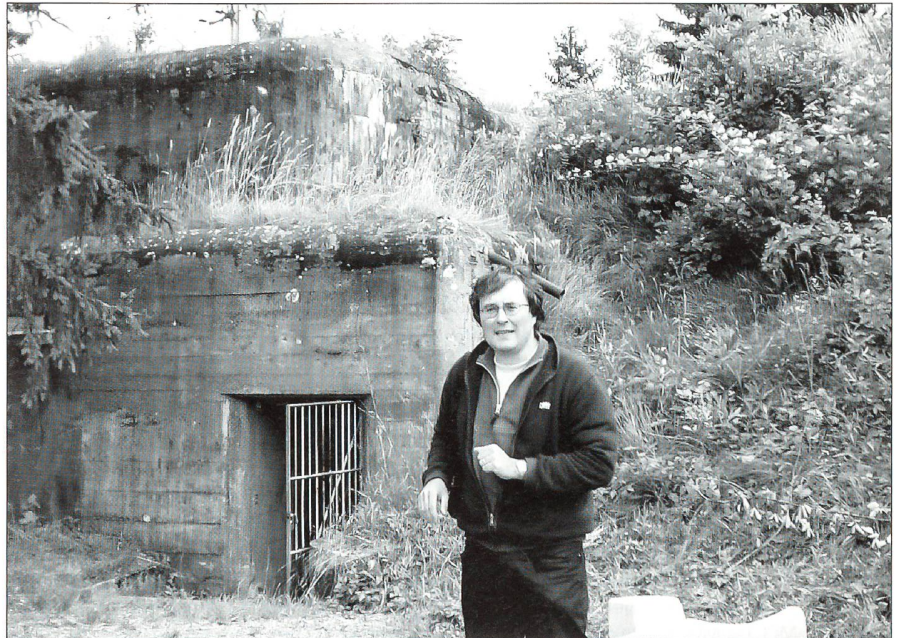
Hansjörg Brem, Adjunkt des Amtes für Archäologie des Kantons Thurgau, vor dem Infanteriewerk Bahndamm in Lengwil.
