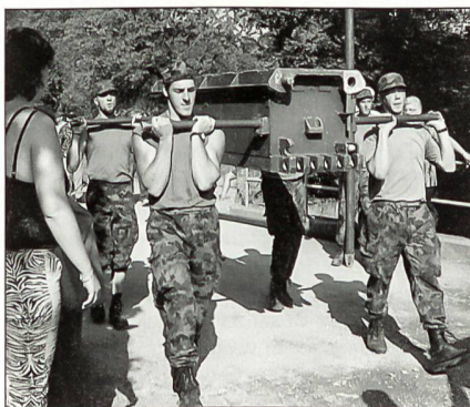
Die Brücke für grosse Fahrzeuge wird aus schweren Einzelteilen zusammengebaut.
