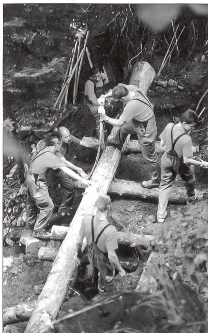
Instandstellungsarbeiten nach Unwetter im Emmental.
