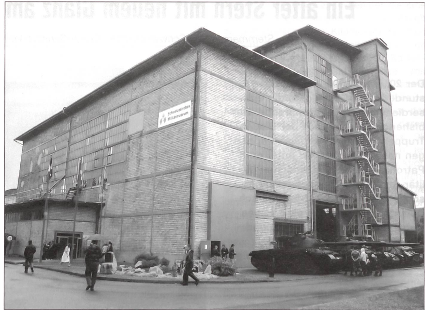
Aussenansicht der Museumshalle.
