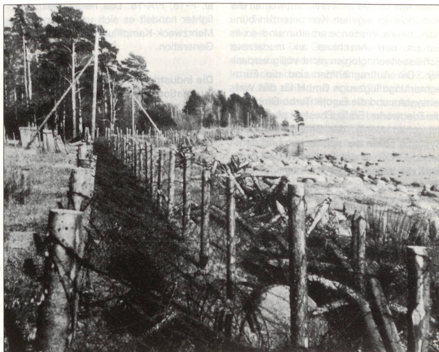
Panzerabwehrhindernis vor der Viipuri-Vuoksi-Linie im Bau.
