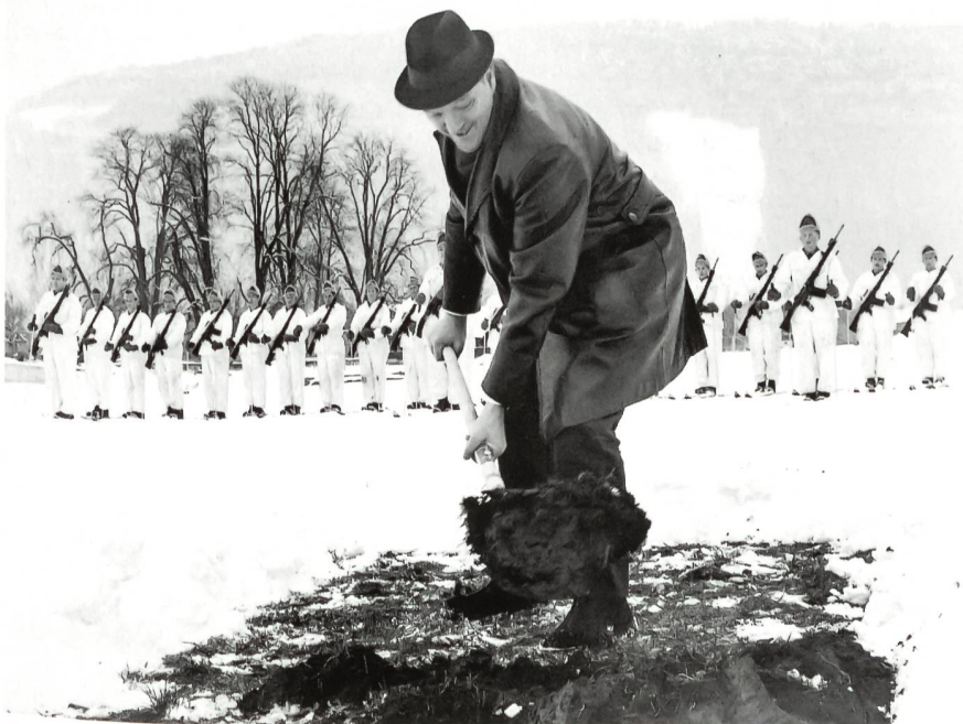
Spatenstich zur Kaserne durch den damaligen Regierungsrat German Murer.
