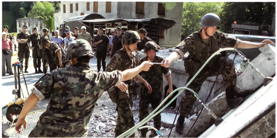
Die Bereitstellung der Betonpresse erfordert Massarbeit.
