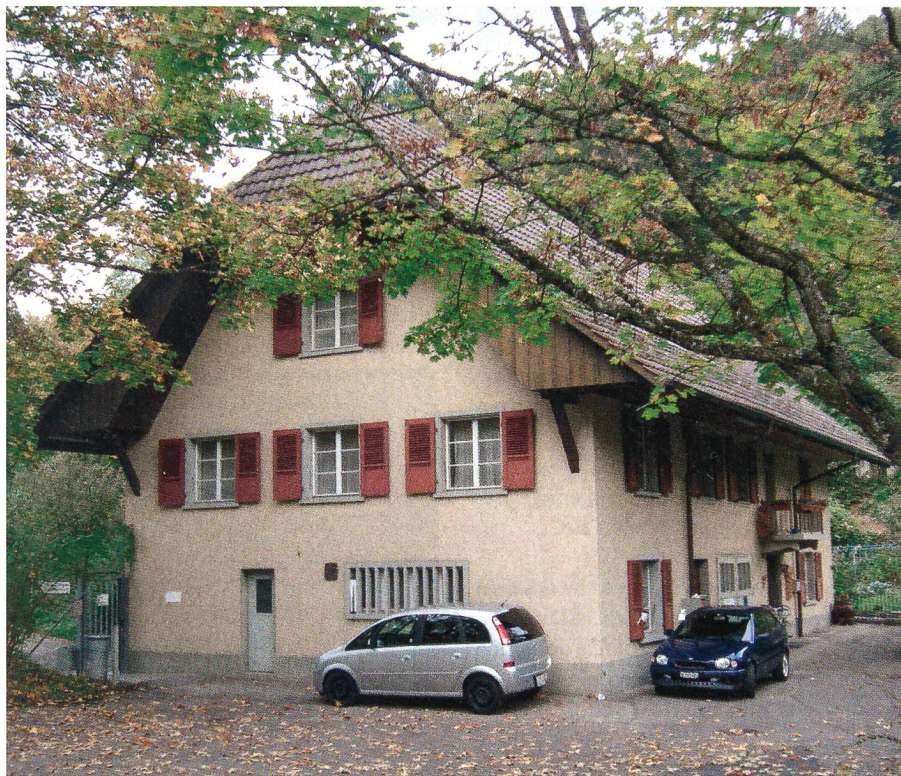
Der «berühmte» KP der P-26 in Oberburg, damals enttarnt durch einen Journalisten.
