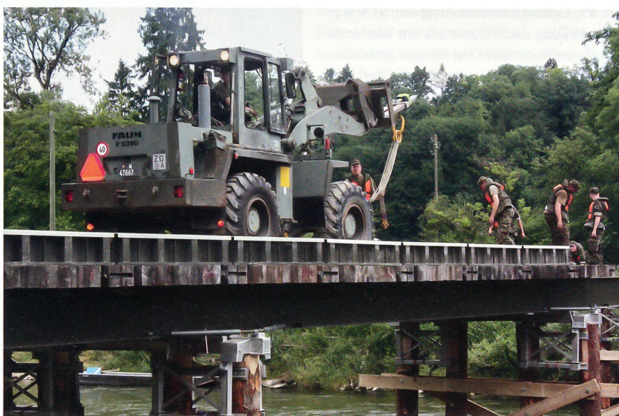
Bei Alten an der Thur: Der PneuLader auf der Stahlträgerbrücke.
