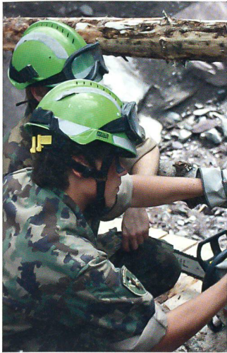
Die Schlammlawine zerstörte mehrere Brücken. Die Durchdiener bauen sie wieder auf.
