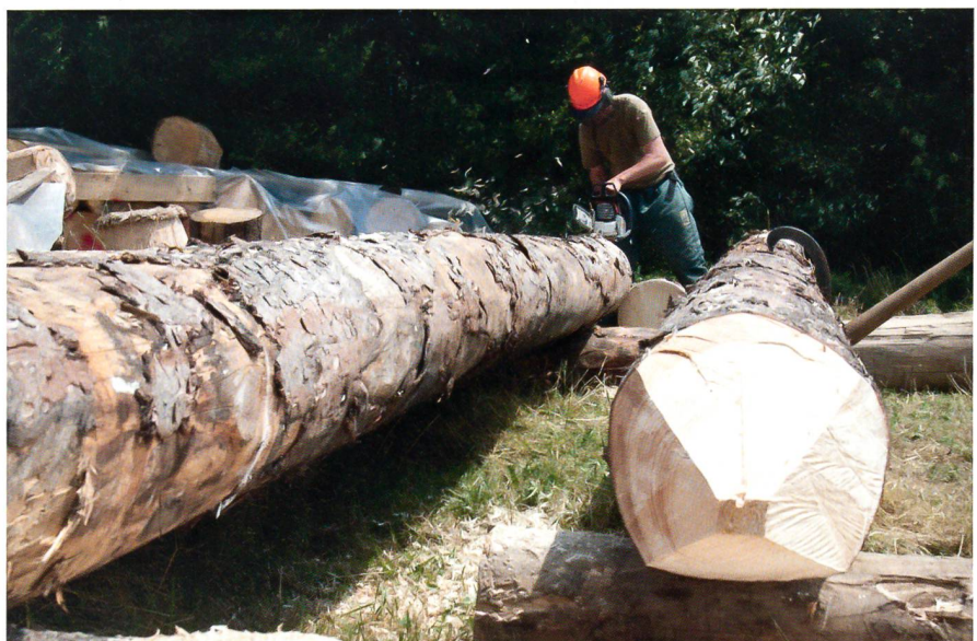
Die mit dem Helikopter eingeflogenen Pfähle werden zurechtgeschnitten.
