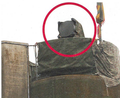
Das Richtstrahlgerät R-905 auf dem Silo.
