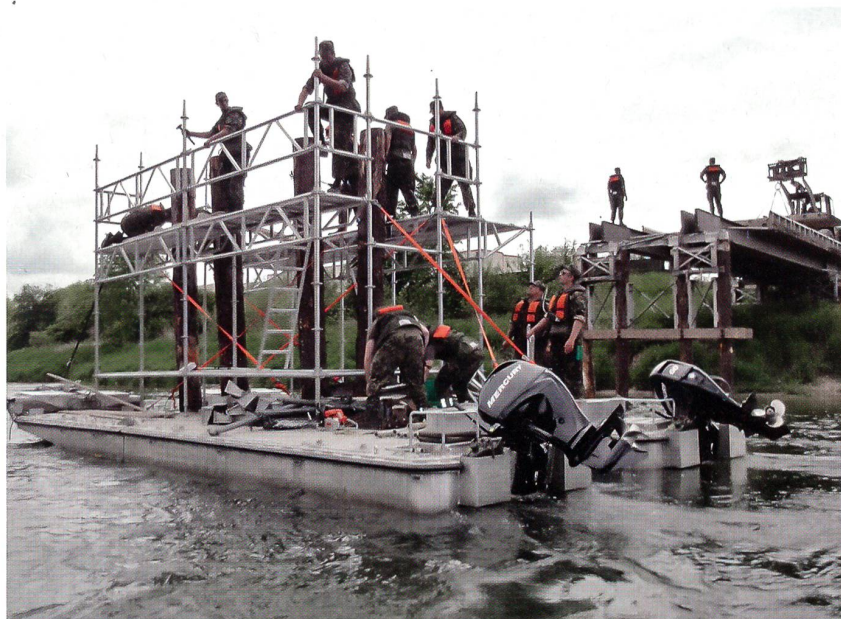
Amlikon: Soldaten des Katastrophenhilfebataillons 4 bauen eine behelfsmässige Brücke über die Thur. Die Tragkraft der Brücke beträgt stolze 70 Tonnen.
