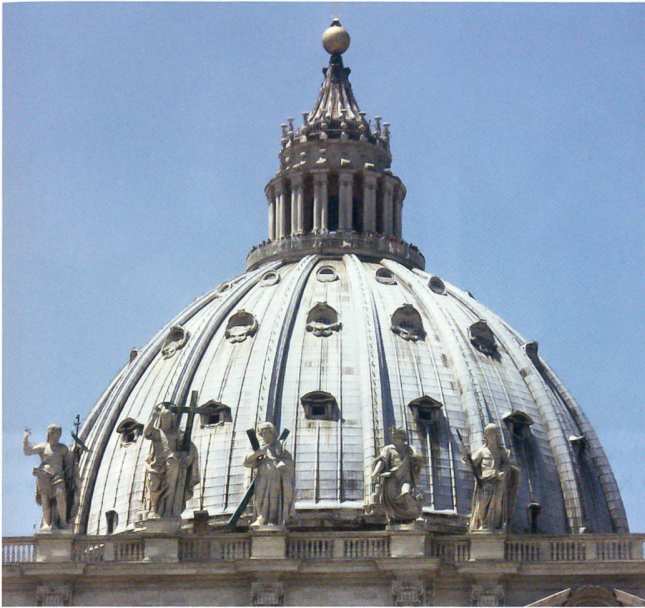
Die Peterskuppel, grösstes freitragendes Ziegelbauwerk der Welt.
