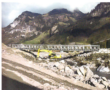
Mabey & Johnson Brücke über die Kander (November 2011).
