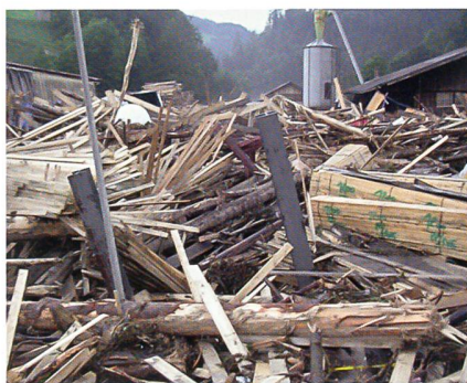
Verkläsung oberhalb der Werkbrücke Sägerei in Kien.
