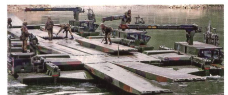
Modernes Brücken- und Fährsystem.
