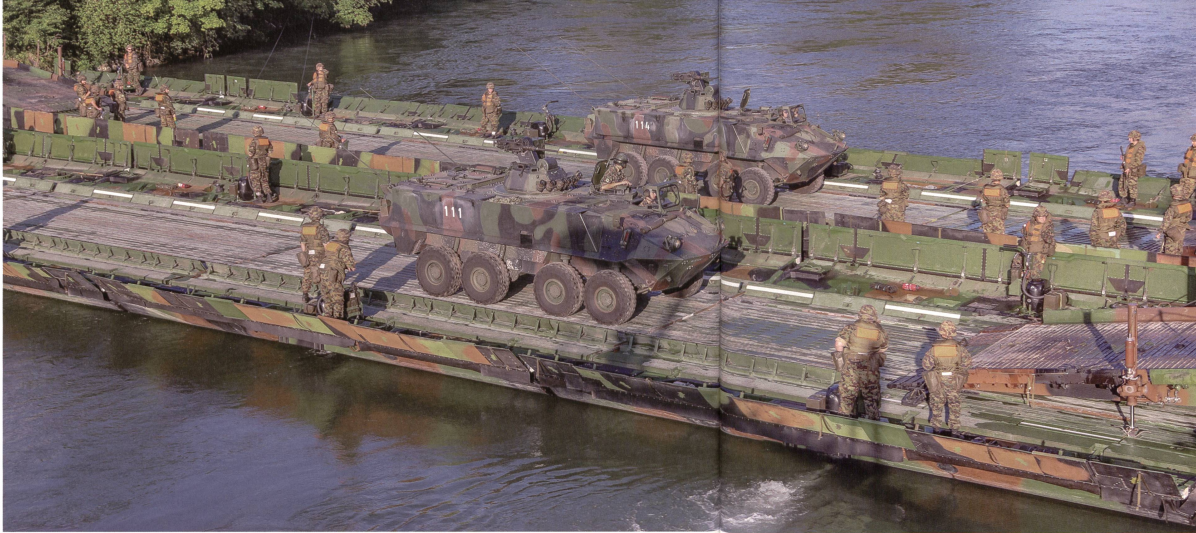
Zwei Piranha-Radschützenpanzer überqueren die Doppelbrücke des Pont Bat 26.
