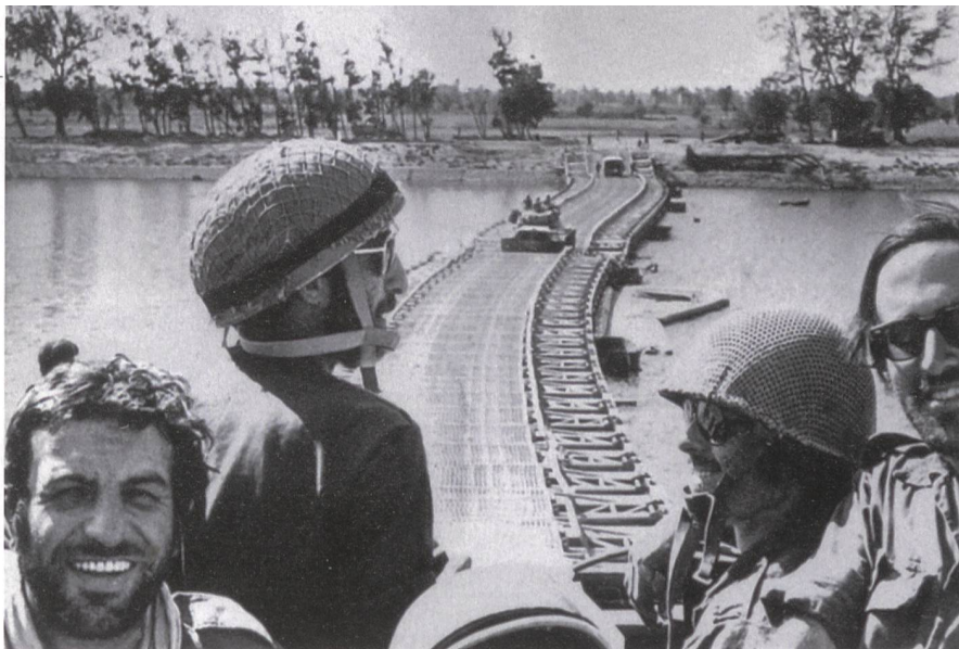
Israels 180 Meter lange, 400 Tonnen schwere Rollbrücke über den Suezkanal.
