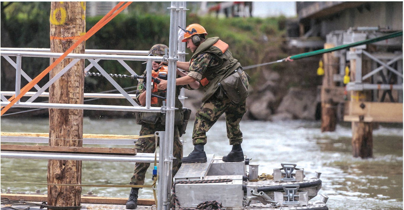
Rampfontoniere beim Bau von Brückenpfeilern.
