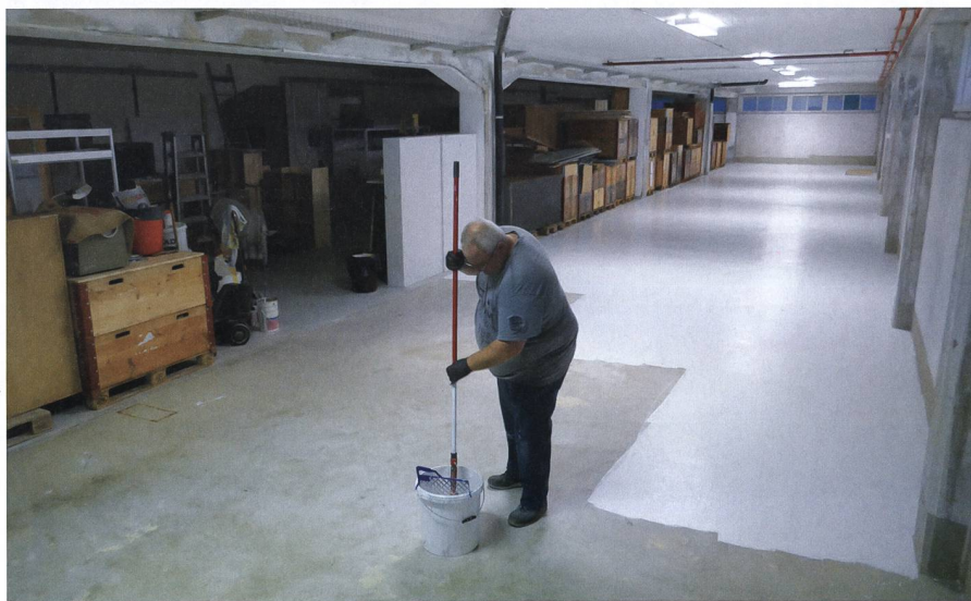
Alleine aber nicht einsam: Während hier in diesem Raum der Boden neu gestrichen wird, wird in den anderen Räumlichkeiten ebenfalls hart gearbeitet.
