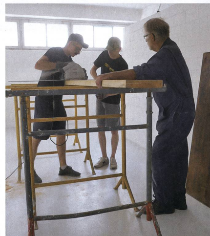
Generationenübergreifend packen die Mitglieder und Gönner auf der Mammutbaustelle mit an.
