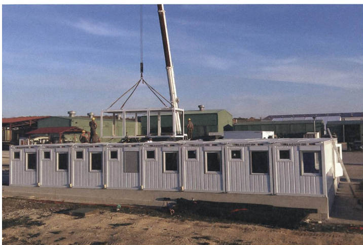
Der Bau nimmt Form an. Im Frühling 2018 wurde der Bau im Camp Novo Selo fertiggestellt.
