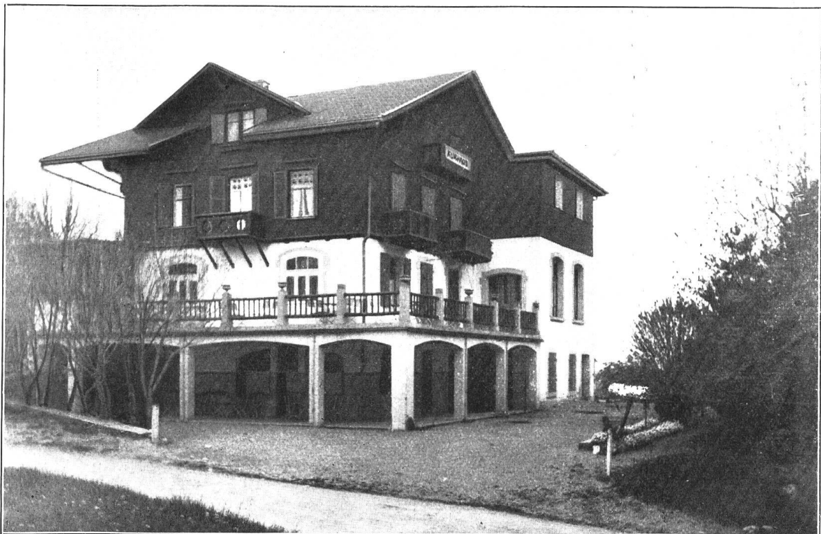
Ansicht von der Ostseite, rechts der Anbau mit dem großen Speisesaal.
