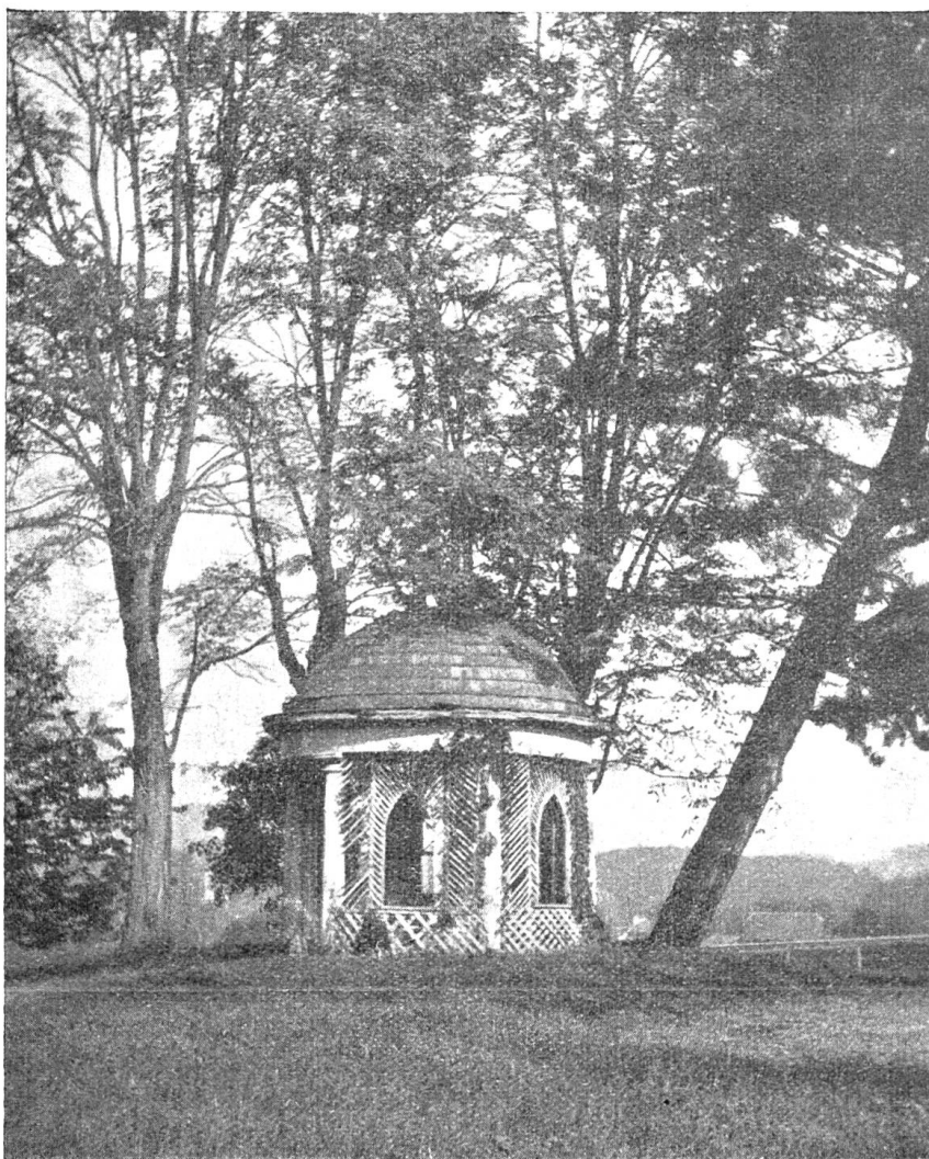
Pavillon in Wabern, nun abgebrochen.
