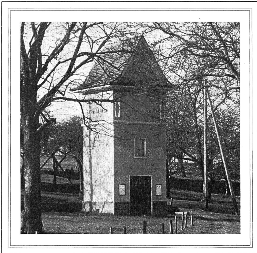
Eine Umformerstation (Transformatorhäuschen) auf dem Lande
