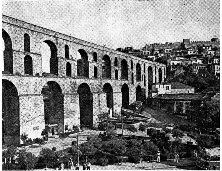
Aquädukt in Kavalla. Solche gewaltige Bauwerke errichteten die Römer vor zweitausend und mehr Jahren, um ihre Städte von weither mit reinem, kostbarem Trinkwasser zu versorgen.
