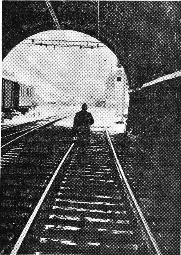
Nach achtstündigem Marsch in der Tunnel- finsternis dem Licht (und frischer Luft) entgegen.
