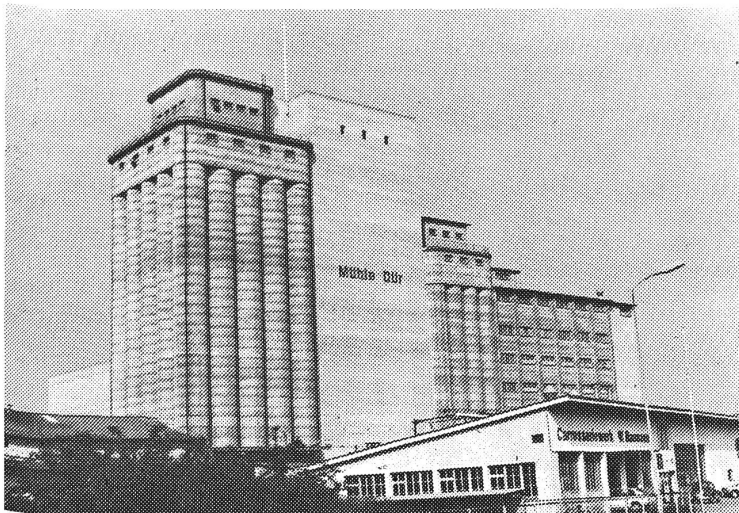
Der Bau des neuen, 47 Meter hohen Getreidesilos der Handelsmühle Hermann Dür AG Burgdorf
