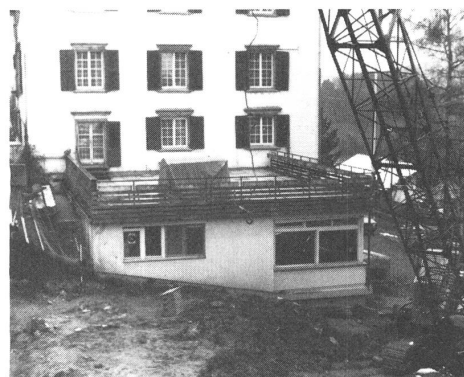
Symbol des Baubeginns. Im Vordergrund der Anbau mit Küche (links) und Speisesaal (rechts).
