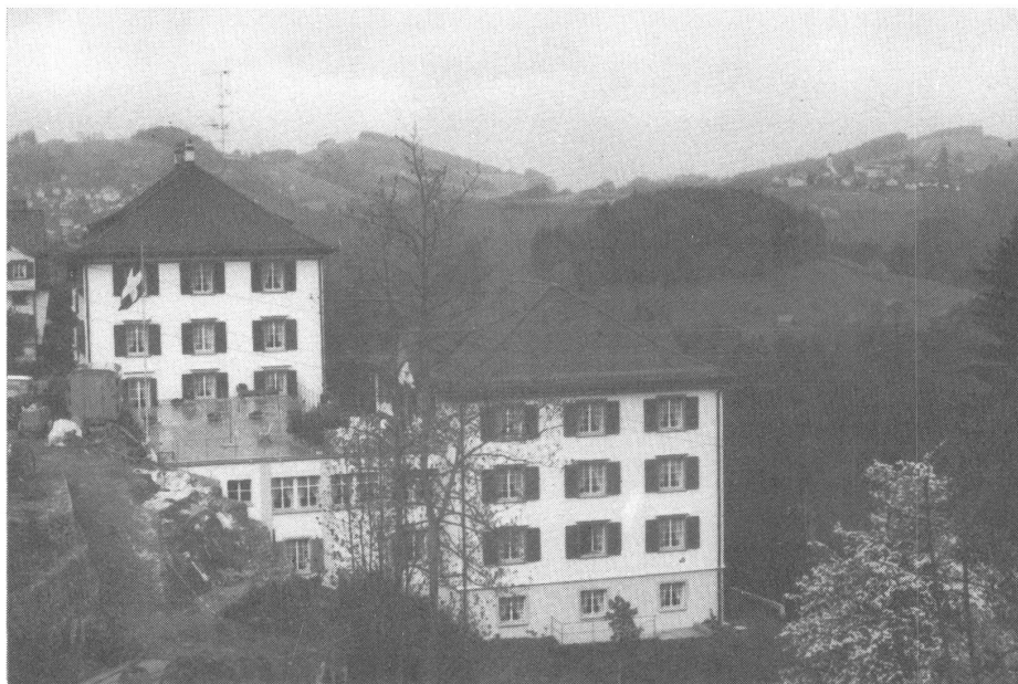
Gesamtansicht des Heimes, links der Altbau.
