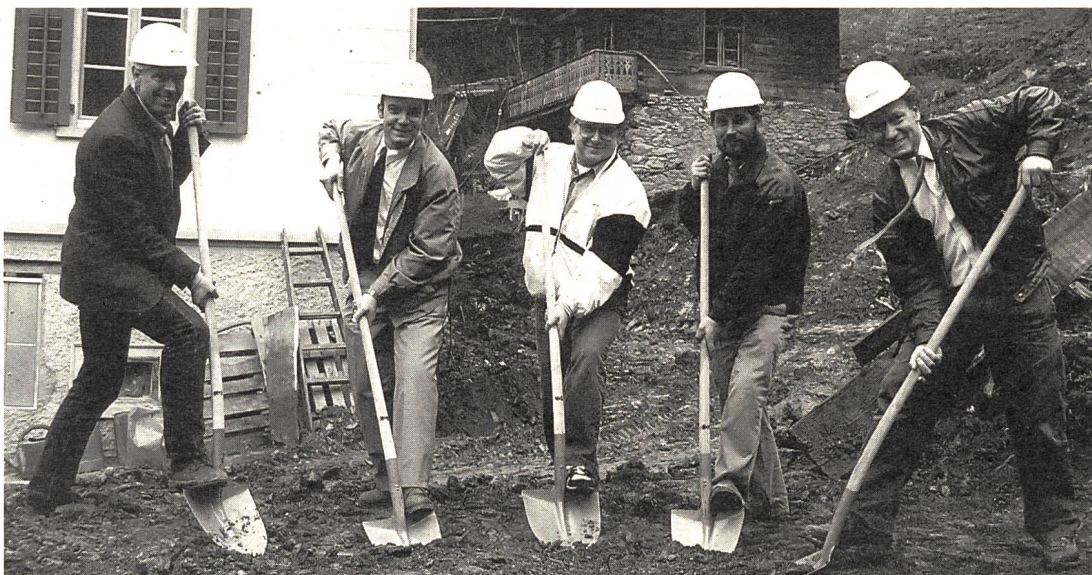
Spatenstich zur zweiten Bauetappe der Bildungsstätte für Hörbehinderte in Passugg: Ernst Casty, Alfredo Isliker, Rolf Zimmermann, Felix Urech und Hans Martin Keller (von links). Foto: Theo Gstöhl
