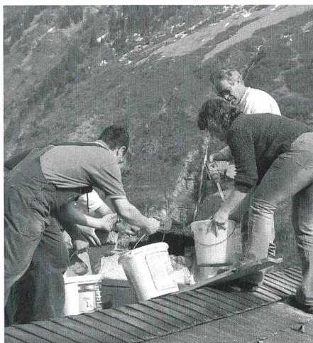
Abbruch des Kamins
