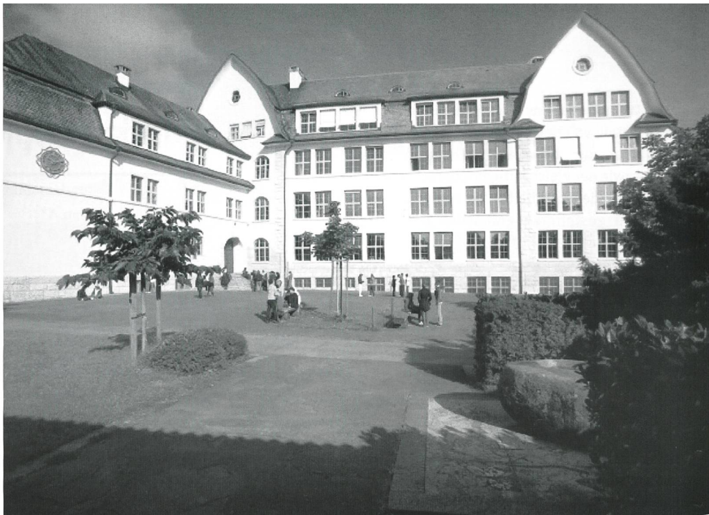
Das altehrwürdige Schulhaus Hans Asper an der Kilchbergstrasse 28 in Zürich-Wollishofen. Das Schulhaus der sek3 – seit nunmehr über 50 Jahren.
