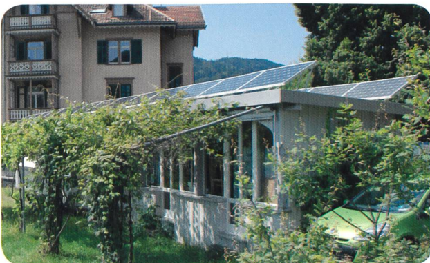
Weiss, flach und auf dem Dach hat es eine Photovoltaikanlage: Die ghe-ces befindet sich im zürcherischen Wald, direkt neben der Stiftung Procom.
