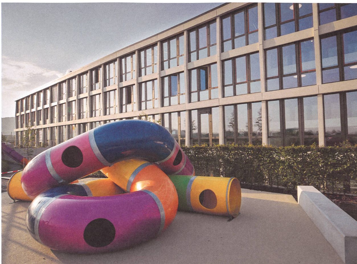
Das neue Fachzentrum in Aesch, das sich über insgesamt sieben Stockwerke (zwei davon unterirdisch) erstreckt.
