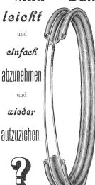
zeigt, wie die beiden endlosen Drähte des Dunlop-Pneumaties dem Gummi-Mantel fest in seiner Lage halten und es leicht ermöglichen, den Pneumatie von den Stahlreifen zu entfernen. Zur besseren Veranstehendem Bilde aus einer Westwoodfelge ein Stitek herausgenommen worden, während die beiden endlosen Stahldrähte ohne den Gummi-Mantel dargestellt sind. Der endlose Draht links liert
