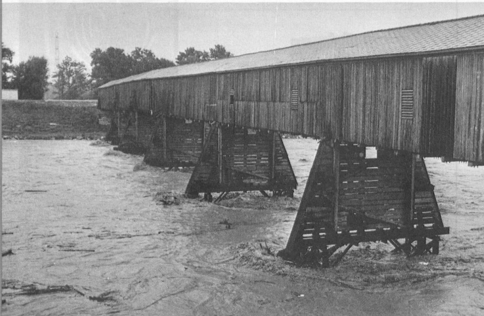
Alte Rheinbrücke zwischen FL und CH.
