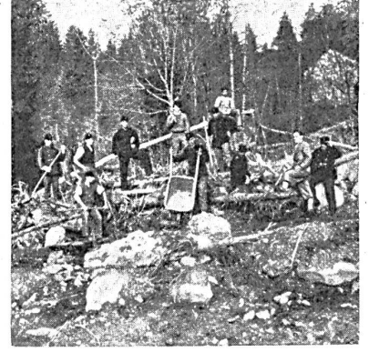
Beginn der Räumung (Unwetterschäden) am Aegerisee
