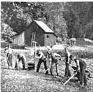
Ausbesserung eines Erdschliffes bei Einsiedeln
