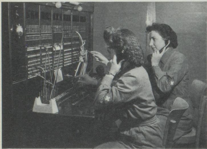
Poste de gué aérien
