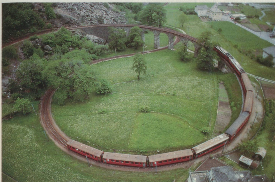
Viaduc en forme de cercle pour franchir la rampe située près de Brusio, dans le Val Poschiavo.
