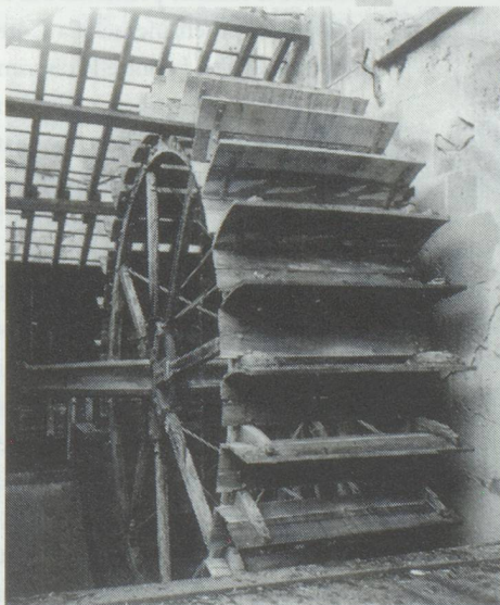
Roue hydraulique de la première fabrique Suchard.
