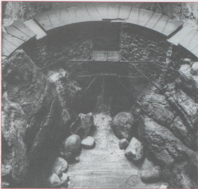
Maquette du barrage, du début du XX e siècle. Vue côté aval, avec avancée en bois (photo : P. Studer).
